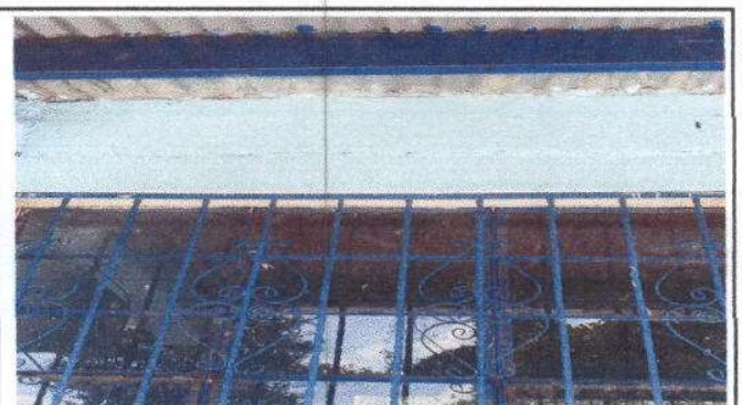
Foto 4: 15.1 Reparación 30 m2 de muro perimetral de block
