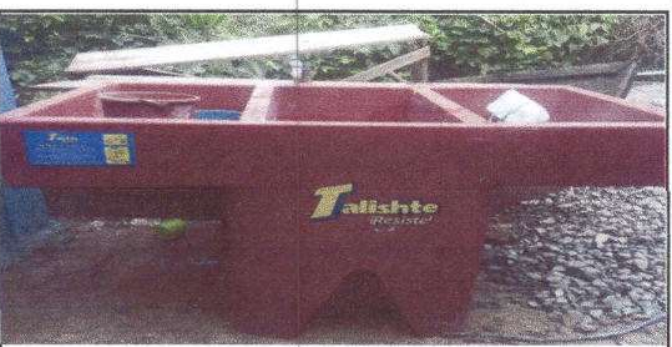
Foto 6: 20.12 Sustitucion de pila plastica de dos lavaderos
